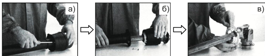
Рисунок 2.4 – Демонтаж защитного ограждения карданного вала
